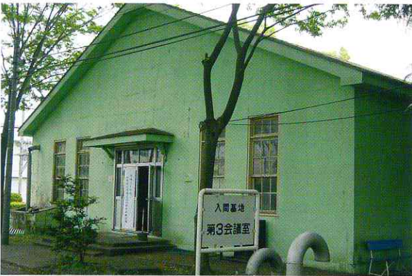
入間基地に残るジョンソン基地時代の建物
