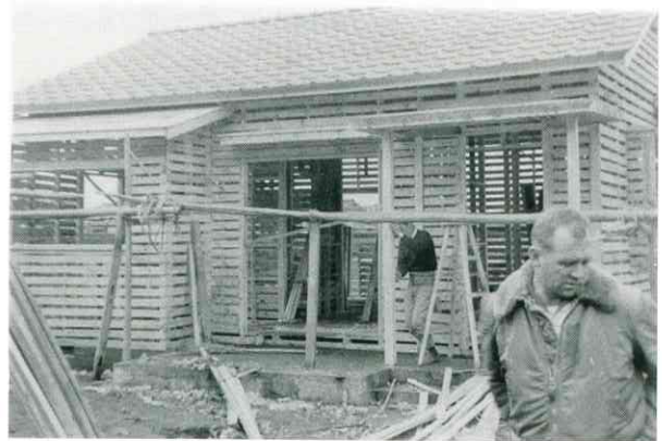
建設中のハウス
